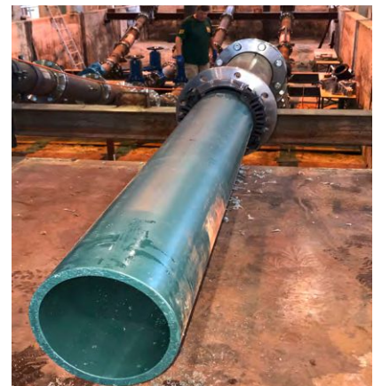
Compact Pipe® Installation, DN200, SDR 17, PE 100 beim IKT Warentest
