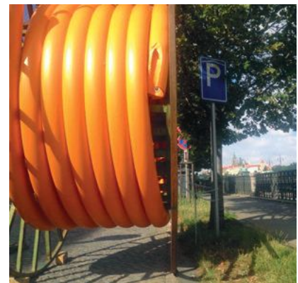
Prag, Innenstadt, DN500, SDR21, Grabenlose Installationen der Zepris s.r.o.
