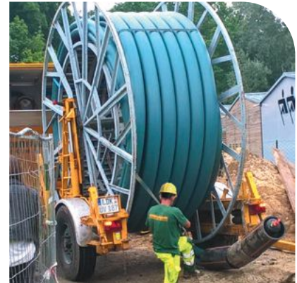
Wolfsburg, Allerpark / VFL Stadion, Abwasser-Druckrohrleitung, DN300, SDR 17, Alternative Verlegung, Diringer & Scheidel
