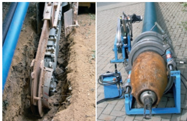
Abb. 16/17: Alternative, sandbettfreie Verlegungen von Wavin SafeTech RC n
