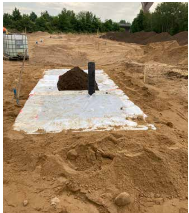
Wenn die Wurzelkammersysteme, wie hier in Schwandorf, mit Verkehrsflächen überbaut werden sollen, muss oberseitig ein Vlies eingebaut werden.
