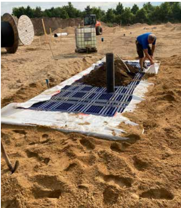
Nach dem Setzen der Wavin TreeTanks wird das Vlies eingeschlagen und ausgerichtet. Das im Vordergrund zu sehende Versickerungsrohr dient sowohl der Be- und Entlüftung als auch der Bewässerung.
