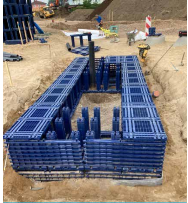
Sechs Meter lang, 2,40 Meter breit und 1,23 Meter tief sind die in Schwandorf eingesetzten Wavin TreeTanks. In der Mitte des Wurzelkammersystems ist ein 1,20 m x 1,20 m großes Pflanzloch vorgesehen.
