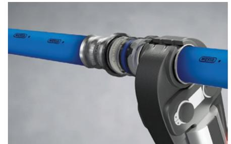
**06** Accione firmemente la herramienta sobre la conexión, hasta lograr que el casquillo reproduzca la forma de la mandíbula de la herramienta en ambos lados según aplique
